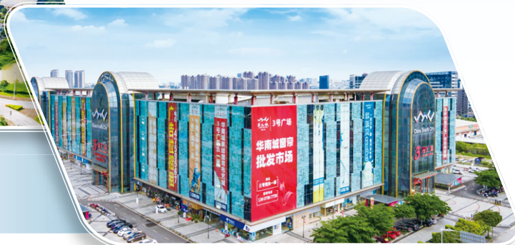
Trade Centre Plaza No. 3 in CSC Nanning 南寧華南城的3號交易廣場
